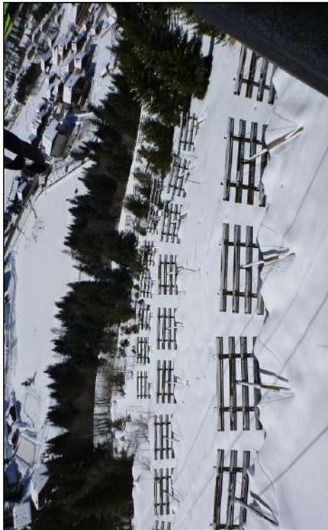
Figure 18: Exemple d’ouvrages mono-ancrages bois (C36)
