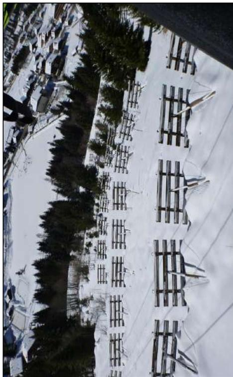
Figure 18: Exemple d’ouvrages mono-ancrages bois (C36)
