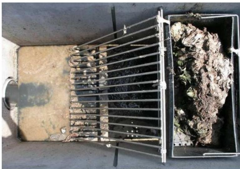
**Photo 5 : Dégrillage manuel par grille oblique en acier inoxydable**
