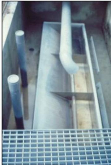
**Photo 2 : Auget basculant**
