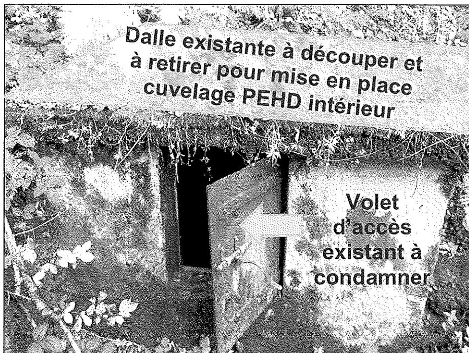
**Figure 13 : Schématisation des interventions à réaliser sur l'ouvrage de captage existant.**
