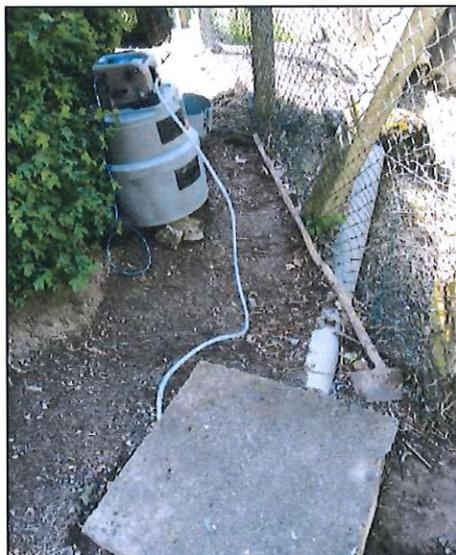
Figure 2-6 : préleveur automatique installé en entrée de STEP.
